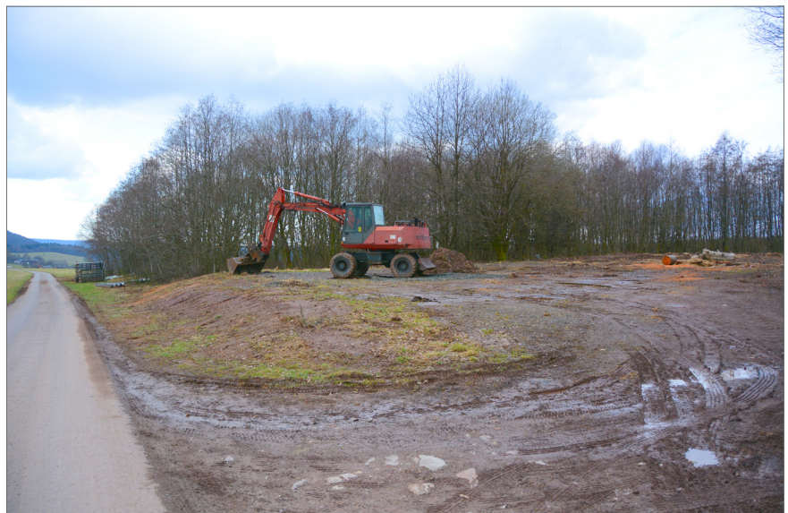
Blick auf die Aufschüttung des alten Sportplatzes (Bauabschnitt I) von Nordwesten
